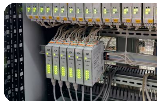
Постовое оборудование системы ЭССО-ИЛС
