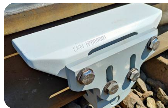
Датчик колеса СКМ
