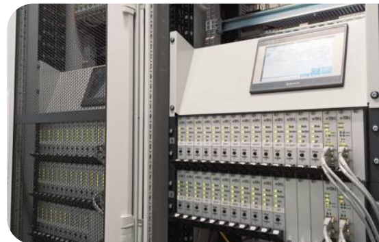
Постовое оборудование системы ЭССО-М-2
