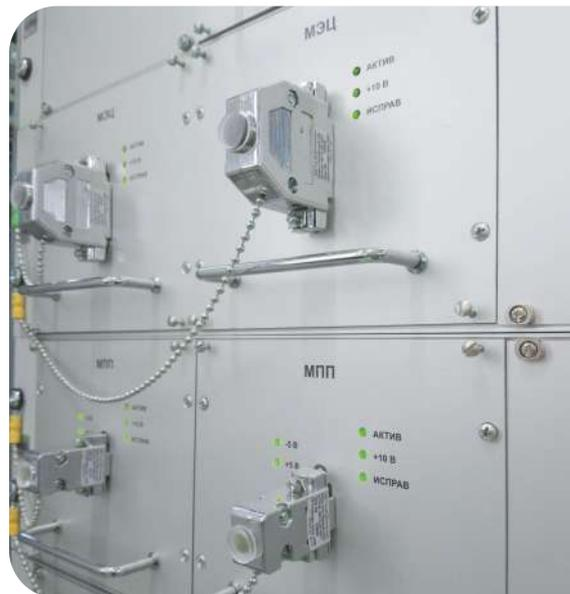
Аппаратура АБТЦ-И выполнена на современной высокопроизводительной микропроцессорной элементной базе без применения электромагнитных реле. В зависимости от требований заказчика в АБТЦ-И реализуются алгоритмы автоблокировки со светофорной 3-значной и 4-значной сигнализацией, автоматической локомотивной сигнализации как самостоятельного средства интервального регулирования (АЛСО), а также системы интервального регулирования с подвижными блоками.
