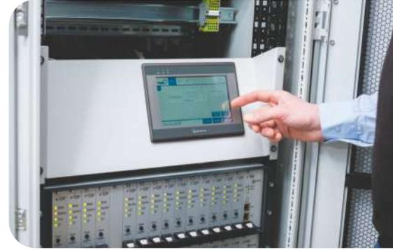
Автоматизированное рабочее место АРМ ЭССО-М/ЭССО-М-2 предназначено для онлайн-наблюдения за состоянием системы на станции, для ведения и просмотра архива системы, оказания помощи эксплуатационному персоналу в поиске и устранении возникающих неисправностей системы.
