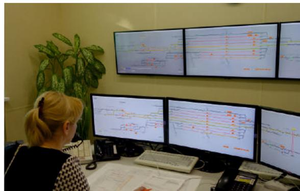
ООО «УГМК-Холдинг», железнодорожная инфраструктура ОАО «СУМЗ». Для увеличения пропускной способности станции, расположенной на расстоянии более 8 км, с помощью ББК-02 организовано удаленное управление и контроль по ВОЛС за ЭССО-М, стрелочными приводами и светофорами. Аппаратура систем ЭССО-М и ББК-02 размещена в релейных шкафах в непосредственной близости от объектов управления.
