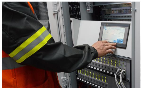
Комплексная модернизация железнодорожного хозяйства заполярного филиала **ПАО «ГМК «Норильский никель»**: **МПЦ-И** 114 стрелок, 147 счетных пунктов **ЭССО** и 131 счетный пункт **ЭССО-М**, 11 переездов **МАПС**, 7 перегонов **МПБ**. Организовано удаленное управление стрелками, установлено 3 модуля **МКМ**, выполнена прокладка 55 км оптико-волоконного кабеля.
