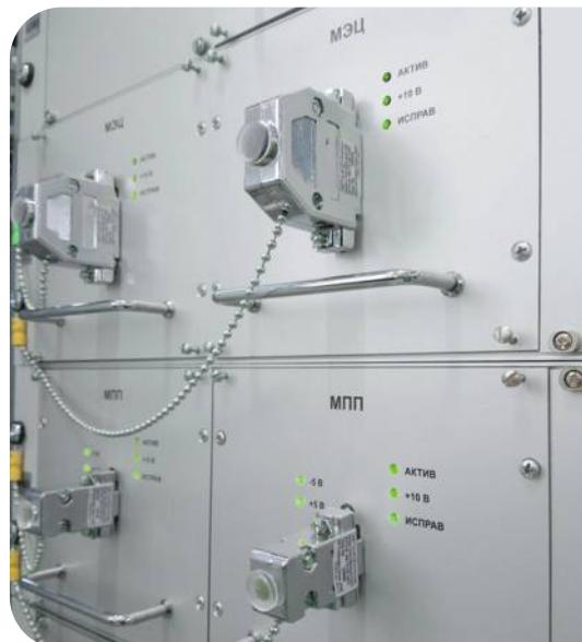
Аппаратура АБТЦ-И выполнена на современной высокопроизводительной микропроцессорной элементной базе без применения электромагнитных реле. В зависимости от требований заказчика в АБТЦ-И реализуются алгоритмы автоблокировки со светофорной 3-значной и 4-значной сигнализацией, автоматической локомотивной сигнализации как самостоятельного средства интервального регулирования (АЛСО), а также системы интервального регулирования с подвижными блок-участками.
