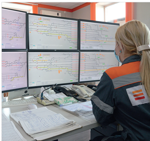
МПЦ-И с режимом мультистанционности на станции Заводская ЕВРАЗ НТМК
