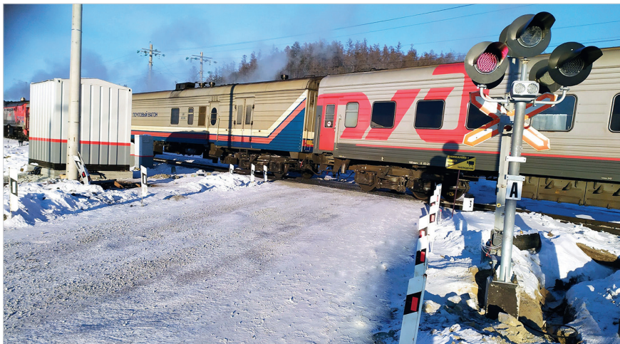
МАПС-М на переезде без дежурного работника
