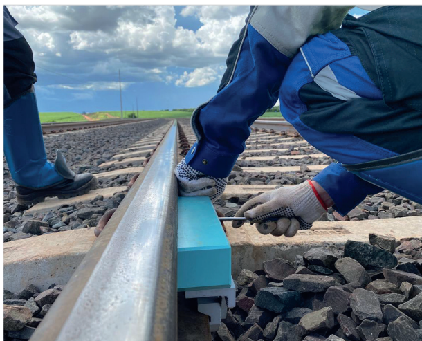
Установка датчика ДКУ-М в Бразилии
