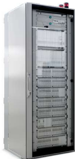
Управляющий контроллер централизации УКЦ
